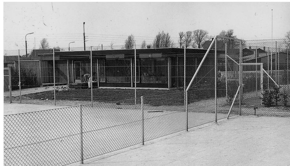
Anlægget på Ettehavevej er ved at være færdigt i 1971
